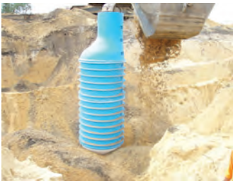
1050mm SMARTPIT™ MANHOLE
